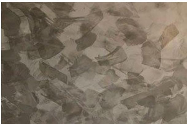
Durch die Überlagerung entsteht die für Fleckspachtelung typische Struktur. Die Farbigkeit wird nach Trocknung gleichmäßiger.
