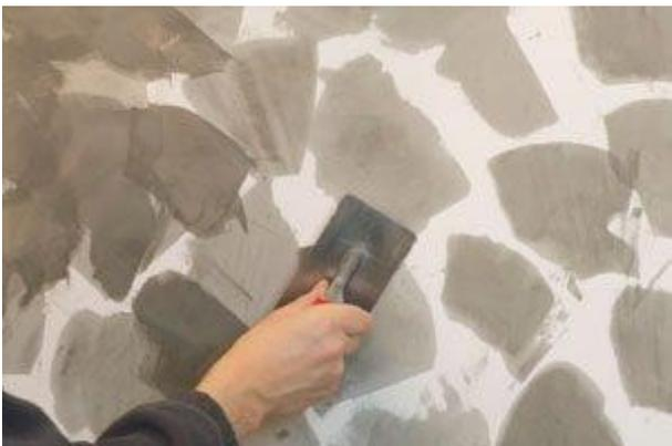
Nach dem Anziehen der ersten Flecken, werden weitere Flecken dazwischen gesetzt.
